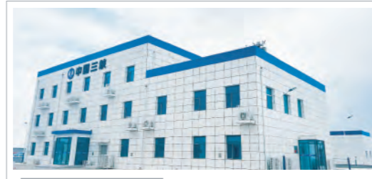
内蒙古乌兰察布180MWh绿色电站示范项目 Ulanqab 180MWh Green Power Station Demonstration Project
