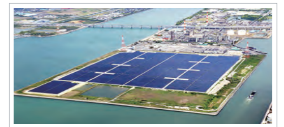
日本大阪6MWh储能项目 The Japan Osaka 6MWh UBE Factory Energy Storage Project
